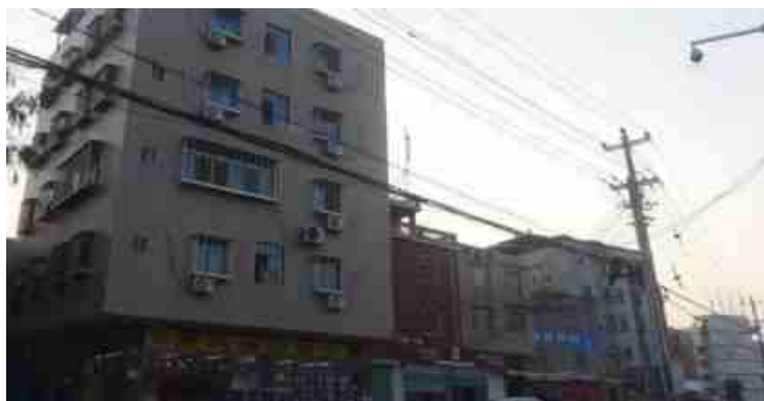
项目南侧的后莲村
